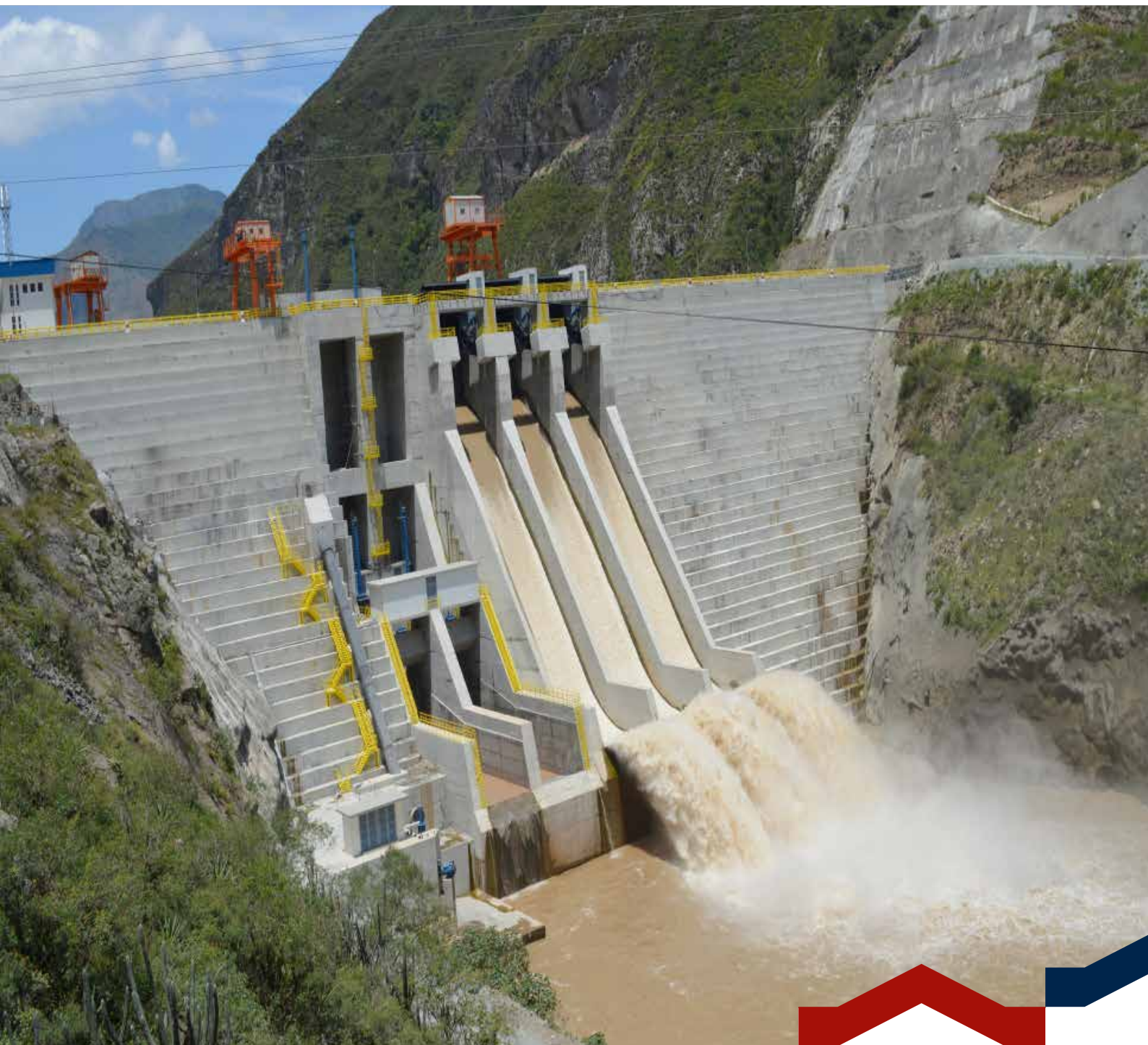
Central Hidroeléctrica Minas San Francisco Fotografía: CELEC EP
