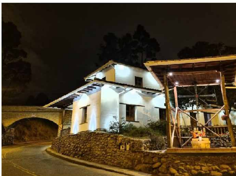
Acueducto que conducía el agua a la planta eléctrica de Yanuncay
