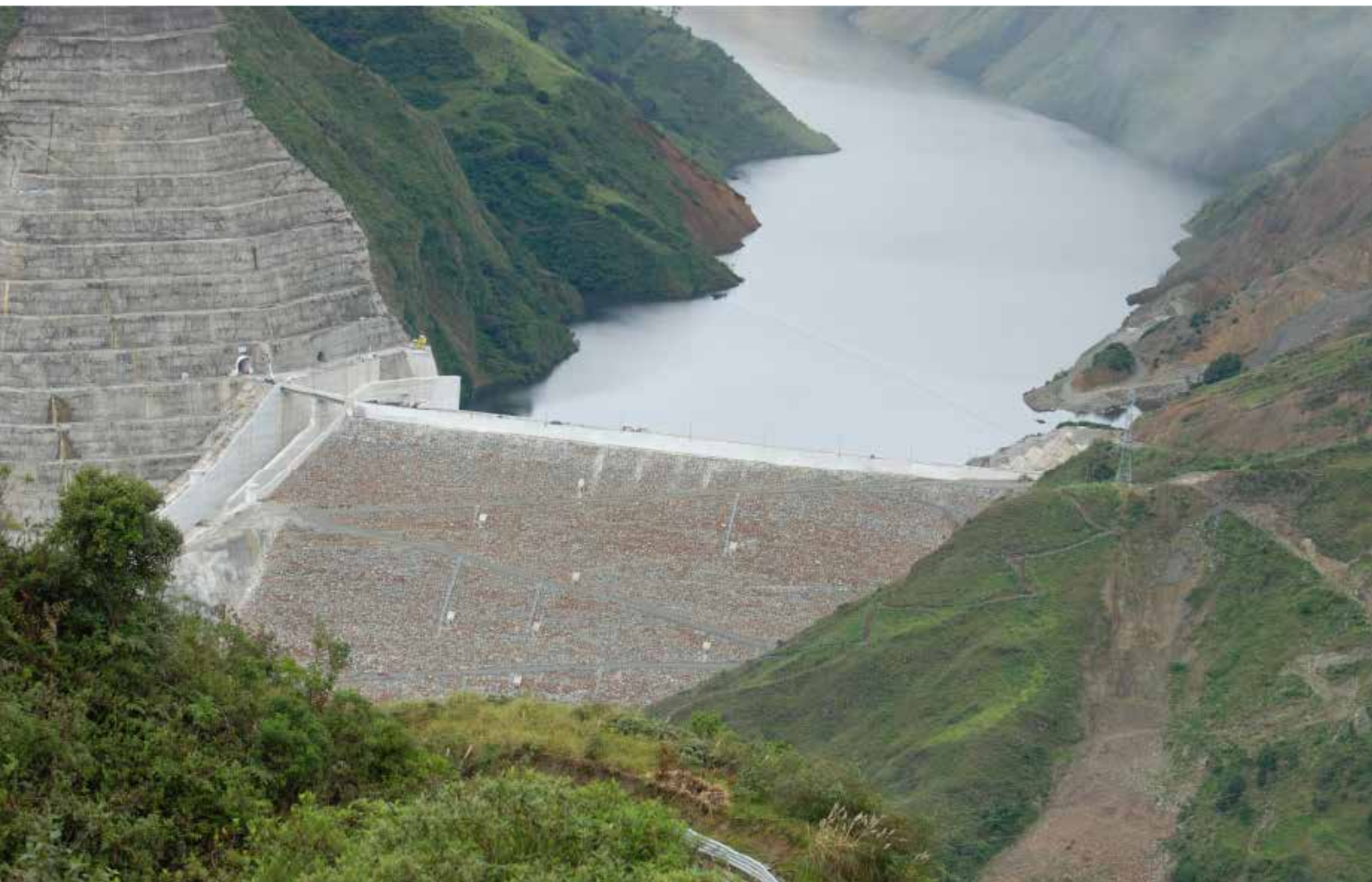
Central hidroeléctrica Mazar
