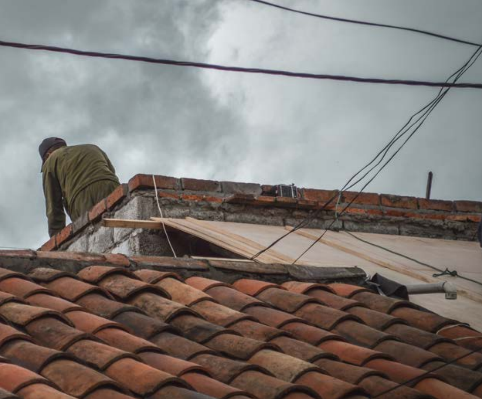
Mantenimiento de la cubierta de una edificación patrimonial en la calle de Las Herrerías. Foto: Nicolás Calle, 2018
