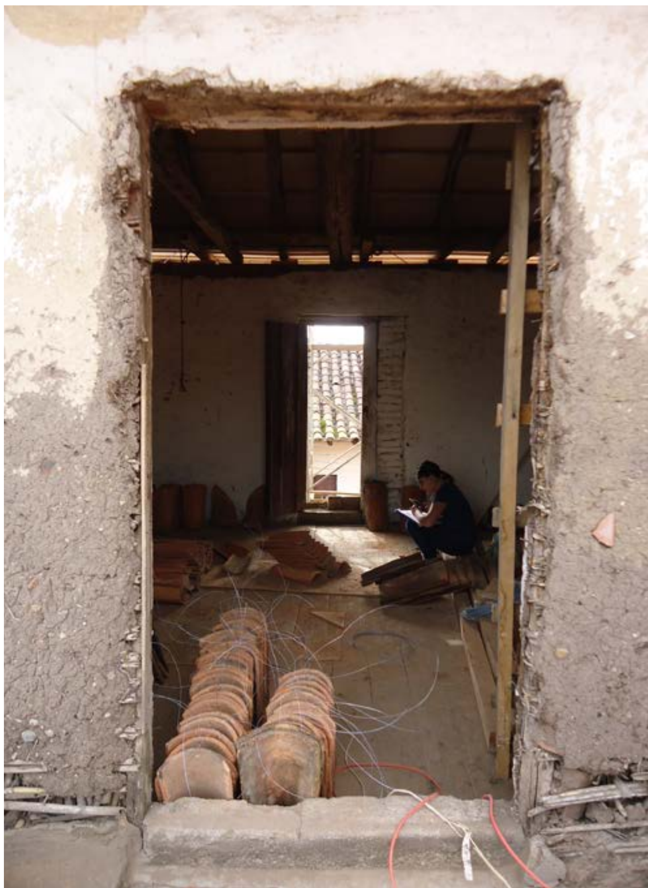
Edificación patrimonial vernácula durante el proceso de intervención. Foto: Proyecto "Ciudad Patrimonio Mundial" (CPM), 2018
