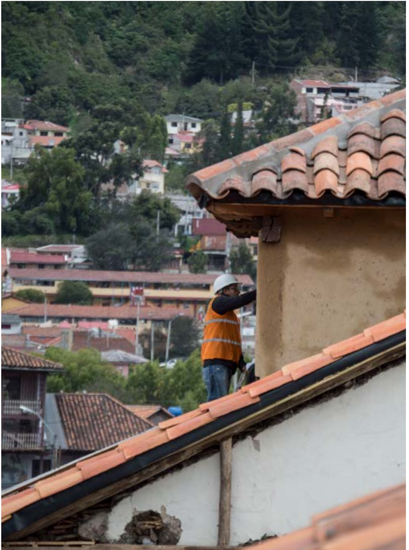
Las obras de mantenimiento en la calle de Las Herrerías concluyeron los primeros días del mes de agosto de 2018. Foto: Wilson Cevallos, 2018
