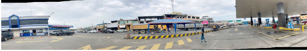
Figura 9. Vista panorámica de la gasolinera y vía a La Troncal.
