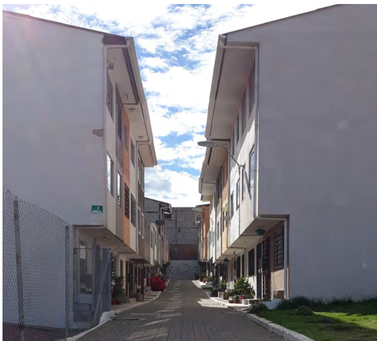
Tipología 1 construida su ampliación
