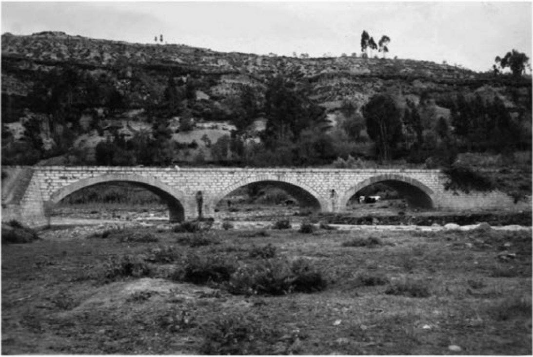
FERROCARRIL SIBAMBE-CUENCA. Puente en Charasol para el paso del Ferrocarril. Kl. 123 12x9 2874
