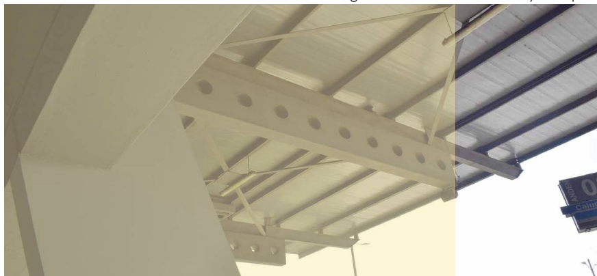
Figura 240: Cubiertas en voladizo
