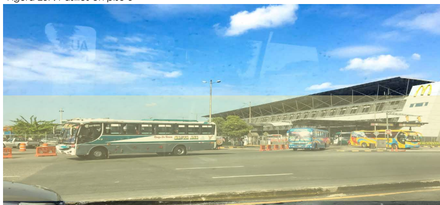
Figura 238: Vista exterior de la salida de buses
