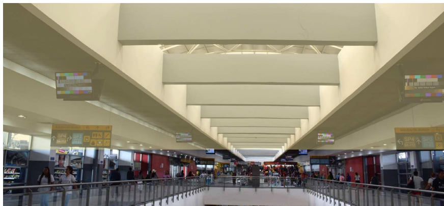
Figura 239: Vanos en cubierta y entrepisos
