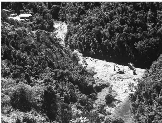
Figura 3. a) Máquinas en el río Santa Bárbara ; b) Río Santa Bárbara (Infiernillos)
