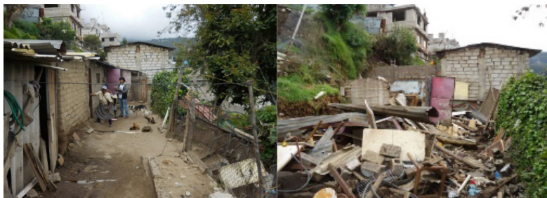
Figura 1. Izq. Casa M28-v21 de la señora Rosa A. en febrero de 2016; Der. Vivienda destruida en abril de 2016.
