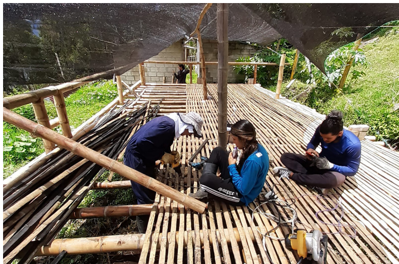
Figura 8. Avance de la construcción del espacio productivo en el Colegio Didascalio, Medellín. Fuente: Equipo de estudiantes UNAL (2020).
