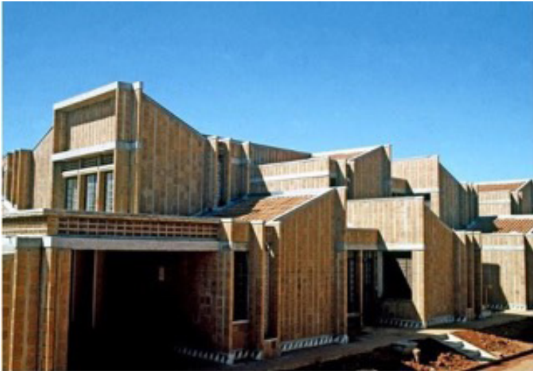
Figura 6. Moradia Estudantil da Unicamp. imagem da época da construção, onde aparecem várias calhas abertas.
