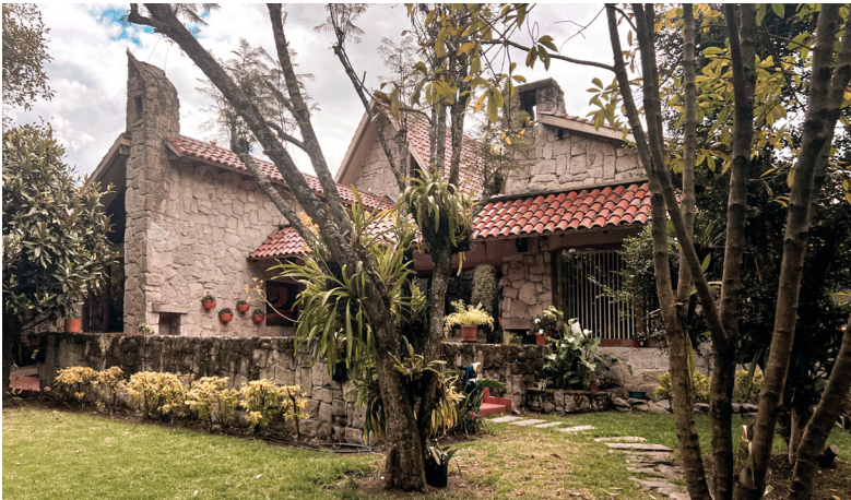
Figura 1. Fachada de la casa.
