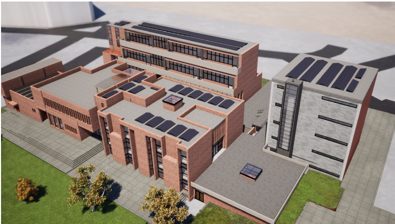
Figura 3. Vista aérea de instalación fotovoltaica sobre cubiertas de edificaciones en la Facultad de Arquitectura y Urbanismo de la Universidad de Cuenca.
