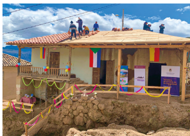
Figura 4. Edificación durante la Campaña de Mantenimiento. Fuente: Astudillo (2021)
