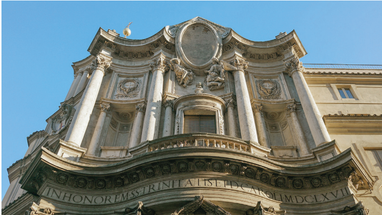
Figura 2. Fachada noroccidental de la iglesia San Carlo alle Quattro Fontane. Roma, Italia.
