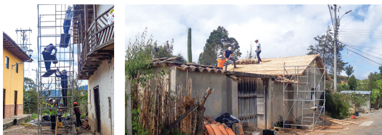
Figura 5-6. Edificaciones vernáculas intervenidas en Cochapata. Fuente: Barsallo (2022)
