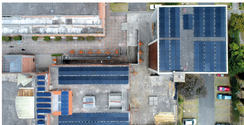
Figura 4. Vista aérea de instalación fotovoltaica sobre cubiertas de edificaciones en la Facultad de Arquitectura y Urbanismo de la Universidad de Cuenca.
