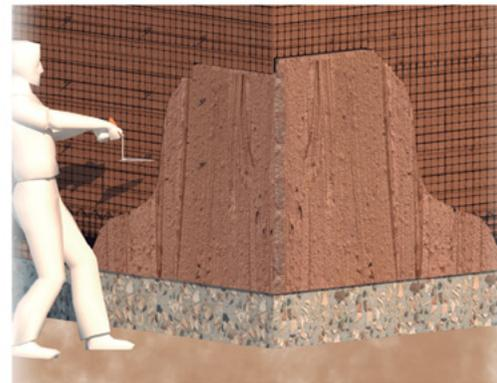
**Paso 8:** una vez que el muro esté terminado hasta la viga collar, se limpia nuevamente la superficie con una escoba o un bailejo. Se coloca la geomalla principal, envolviendo la cara interna y externa del muro y traslapándola sobre la que sobresale del sobrecimiento.
